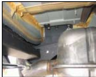
Anbau der AHK, links
